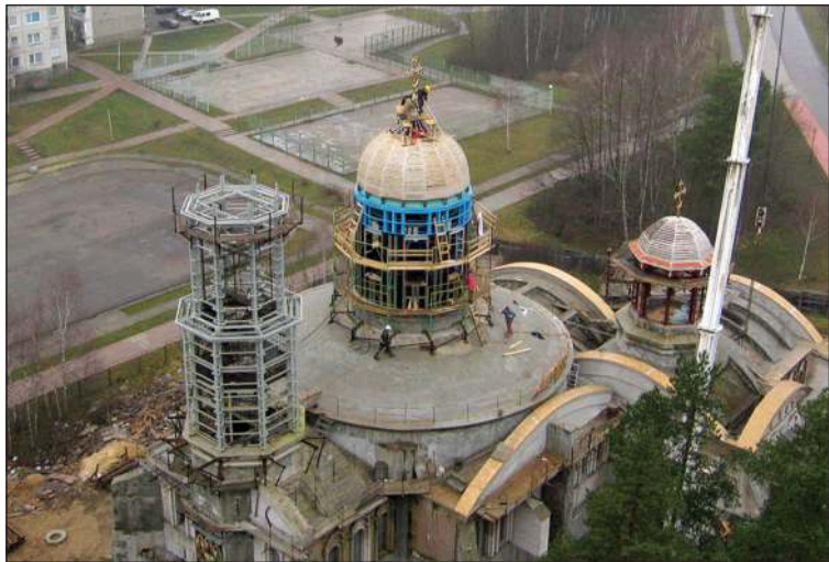
2006 год. Водружение крестов на купола строящегося храма
